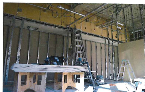
2月 みぎわ園個室化工事開始
